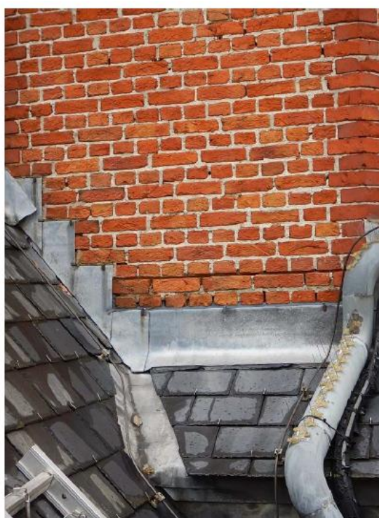
Dak zuid in aansluiting met toren (ref D)
