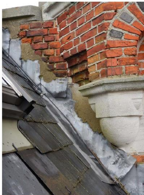
Dak zuid in aansluiting met toren (ref B)
