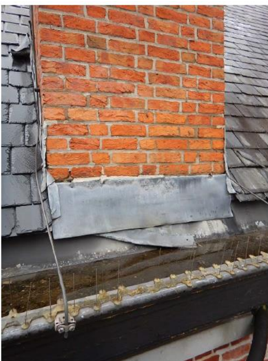
Goot zuid-oost in aansluiting met schouw (ref C)
