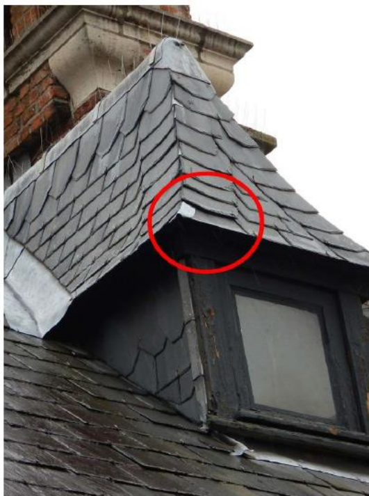
Dak Noord-oost (ref 1)
